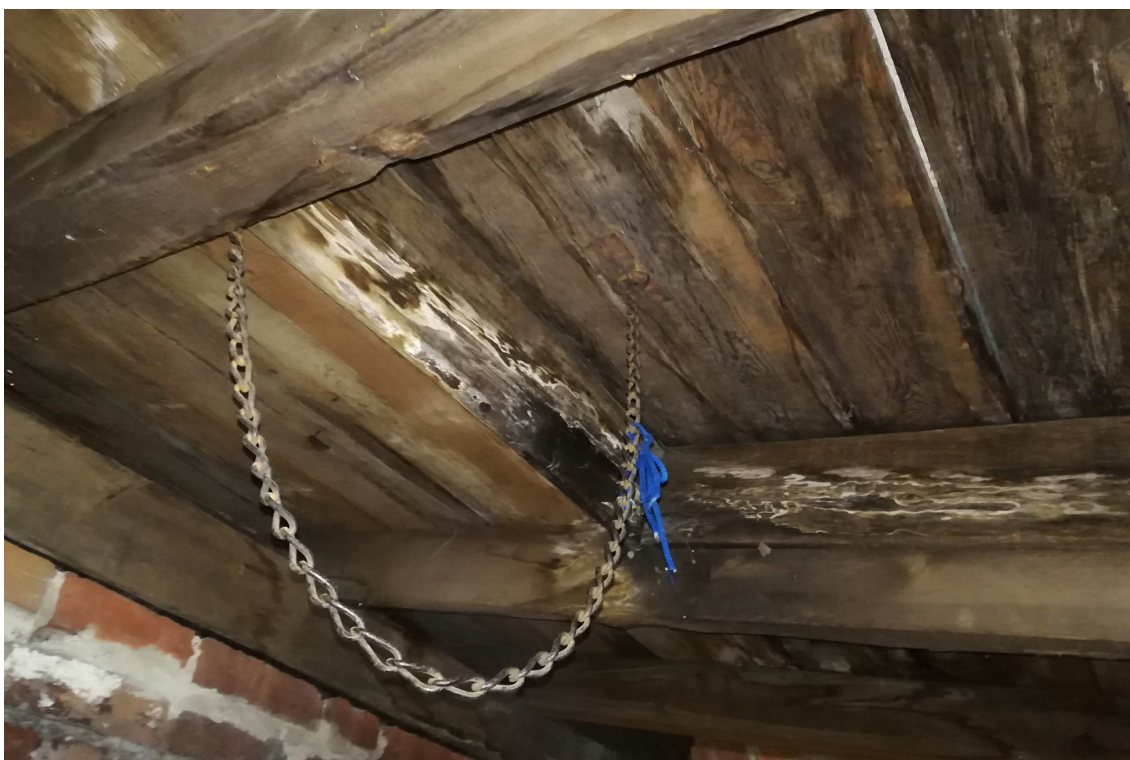
KRZYWA WIEŻA – WYŁĄZ NA DACH
