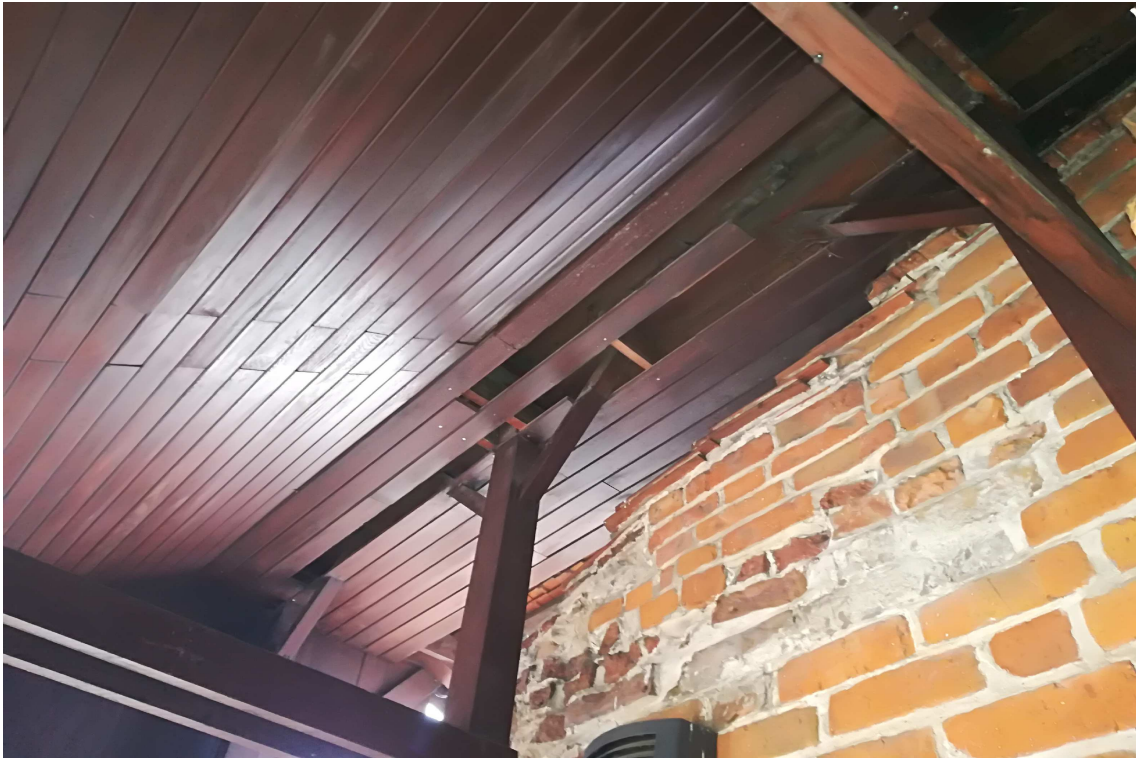
KRZYWA WIEŻA – DASZEK NAD SCHODAMI ZEWNĘTRZNYMI OD STRONY WSCHODNIEJ
