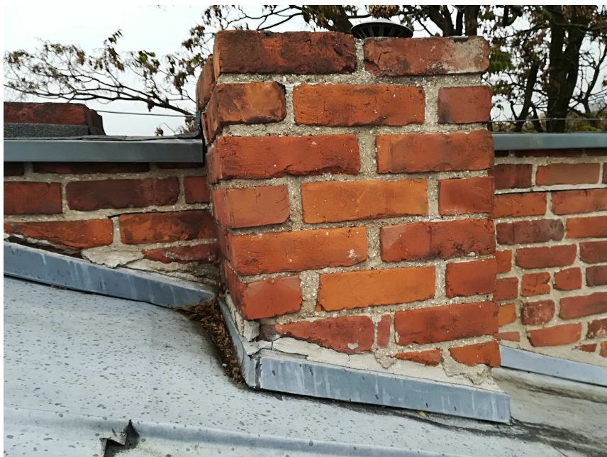
KRZYWA WIEŻA – DACH ( widok w kierunku północnym i zachodnim )
