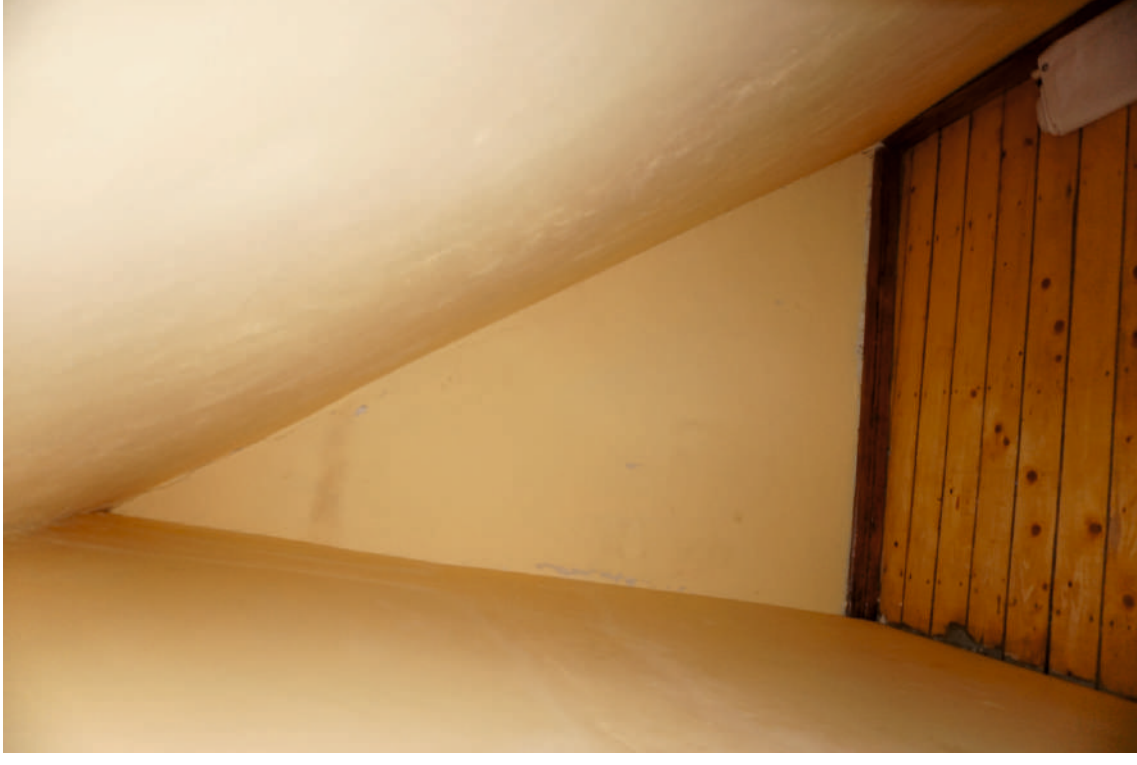
Fot. 20 Poddasze, kraniec zachodni korpusu. Jedno z pomieszczeń magazynowych, pod północną potacją dachu. Widok od zach.
