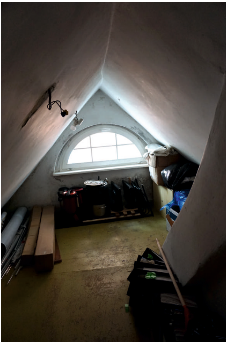
Fot. 26 Poddasze. Niewielkie pomieszczenie nad przedsionkiem. Widok od południa.
