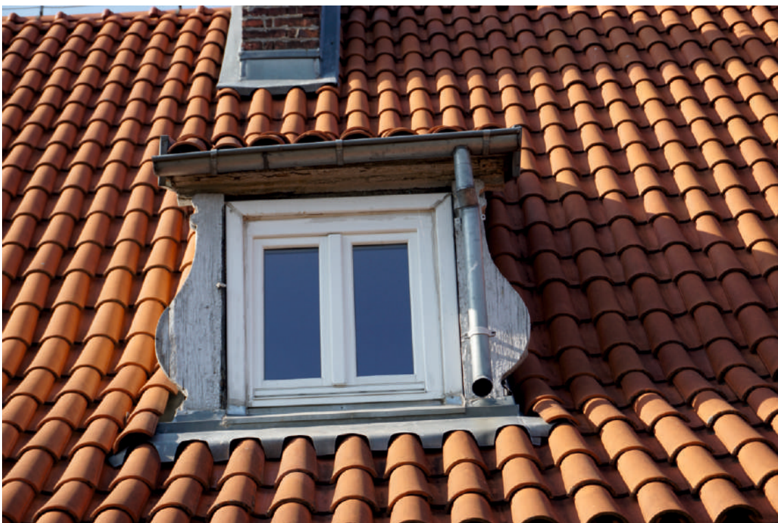
Fot. 48 Lukarna w południowej połaci dachu.
