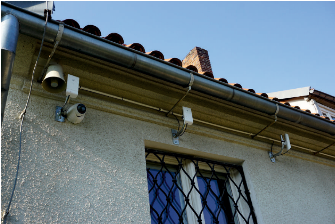
Fot. 53 Natynkowo prowadzone instalacje.
