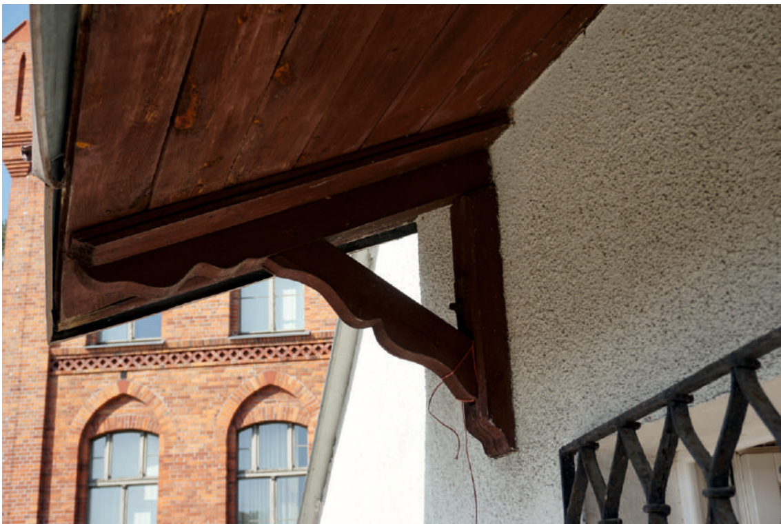
Fot. 44 Taras. Drewniana konstrukcja zadaszenia ponad drzwiami.
