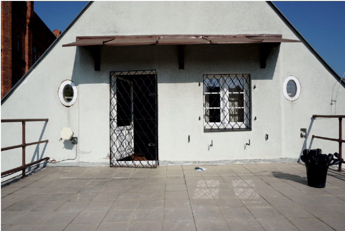
Fot. 21 Taras nad parterową przybudówką. Widok od zach.
