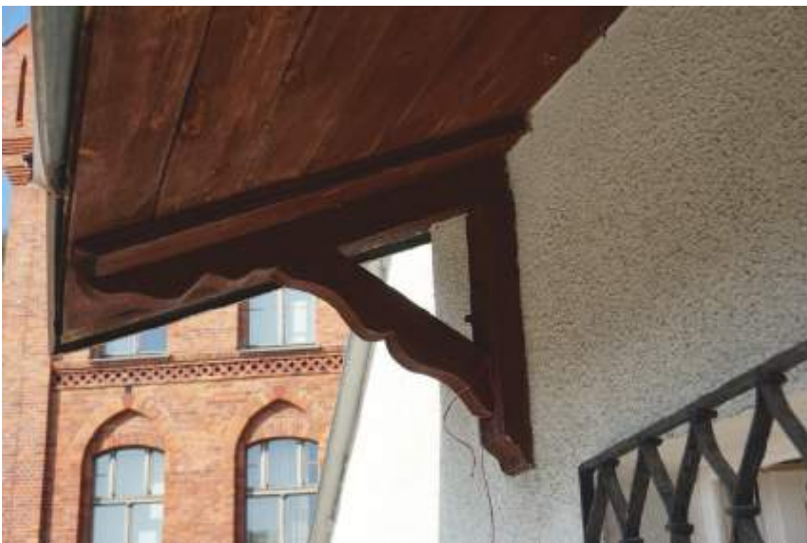
Fot. 44 Taras. Drewniana konstrukcja zadaszenia ponad drzwiami.
