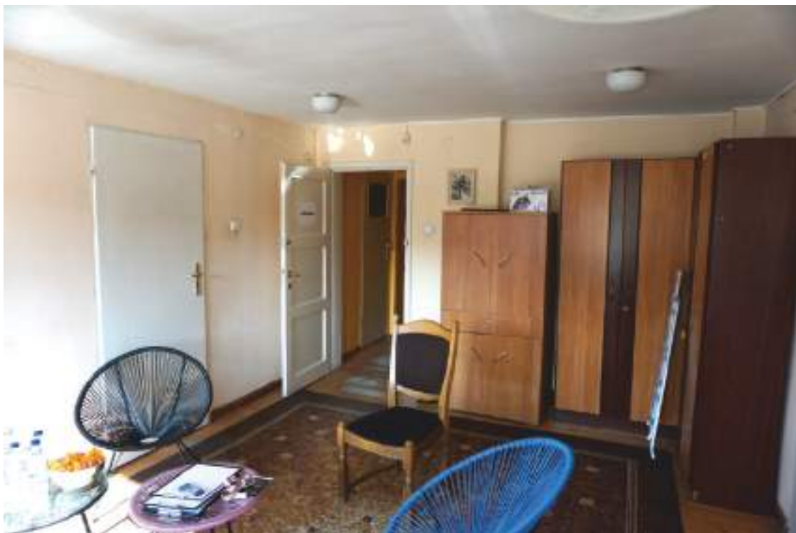
Fot. 17 Poddasze. Pomieszczenie w środkowej części, zachodniego krańca korpusu. Widok od zachodu.
