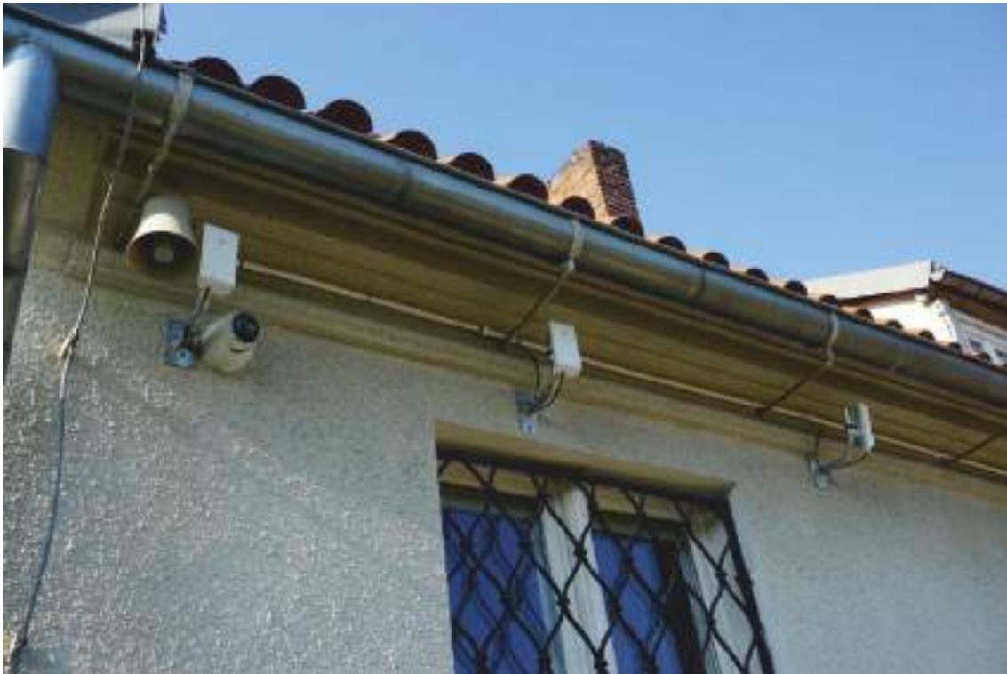
Fot. 53 Natynkowo prowadzone instalacje.
