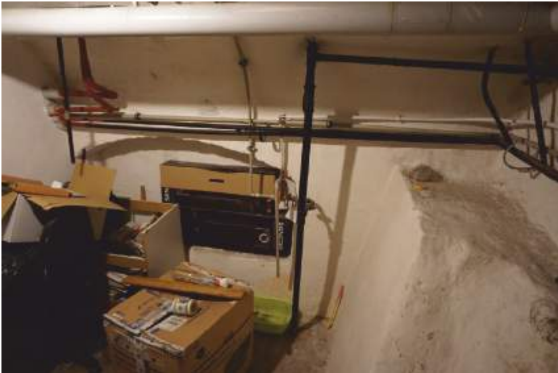
Fot. 5 Piwnica. Niewielkie pomieszczenie w części północnej.
