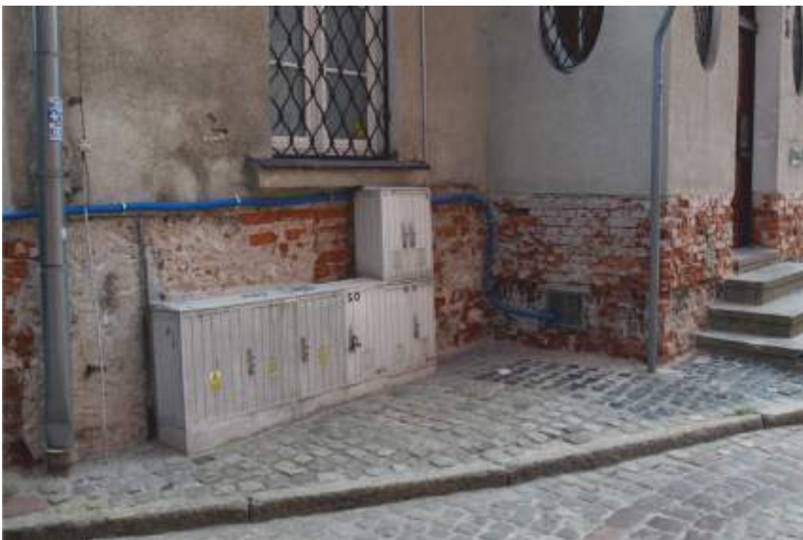
Fot. 54 Elewacja północna - rozdzielcze szafy elektryczne oraz natynkowo prowadzona instalacja gazowa.
