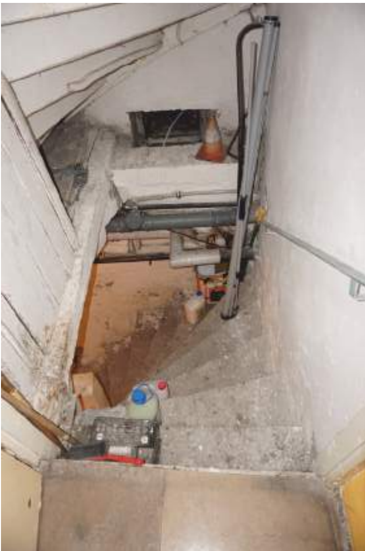
Fot. 6 Piwnica. Betonowe schody komunikujące piwnicę z parterem.
