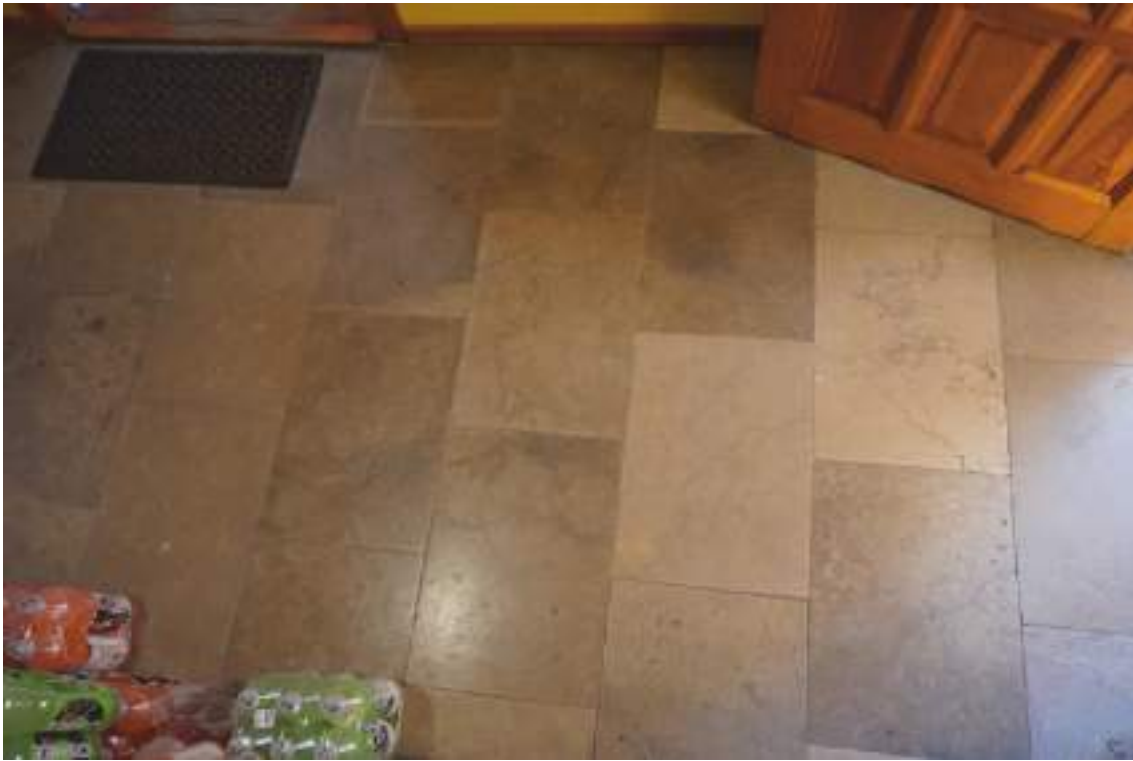
Fot. 51 Współczesna posadzka z wapienia zbitego, wskazana do konserwacji.
