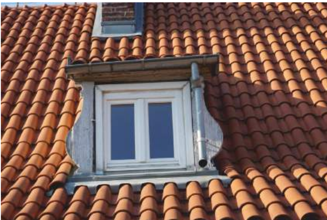
Fot. 48 Lukarna w południowej połaci dachu.
