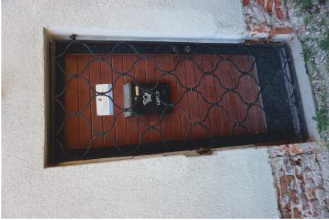
Fot. 49 Współczesne drzwi w elewacji wschodniej, wskazane do prac konserwatorskich.
