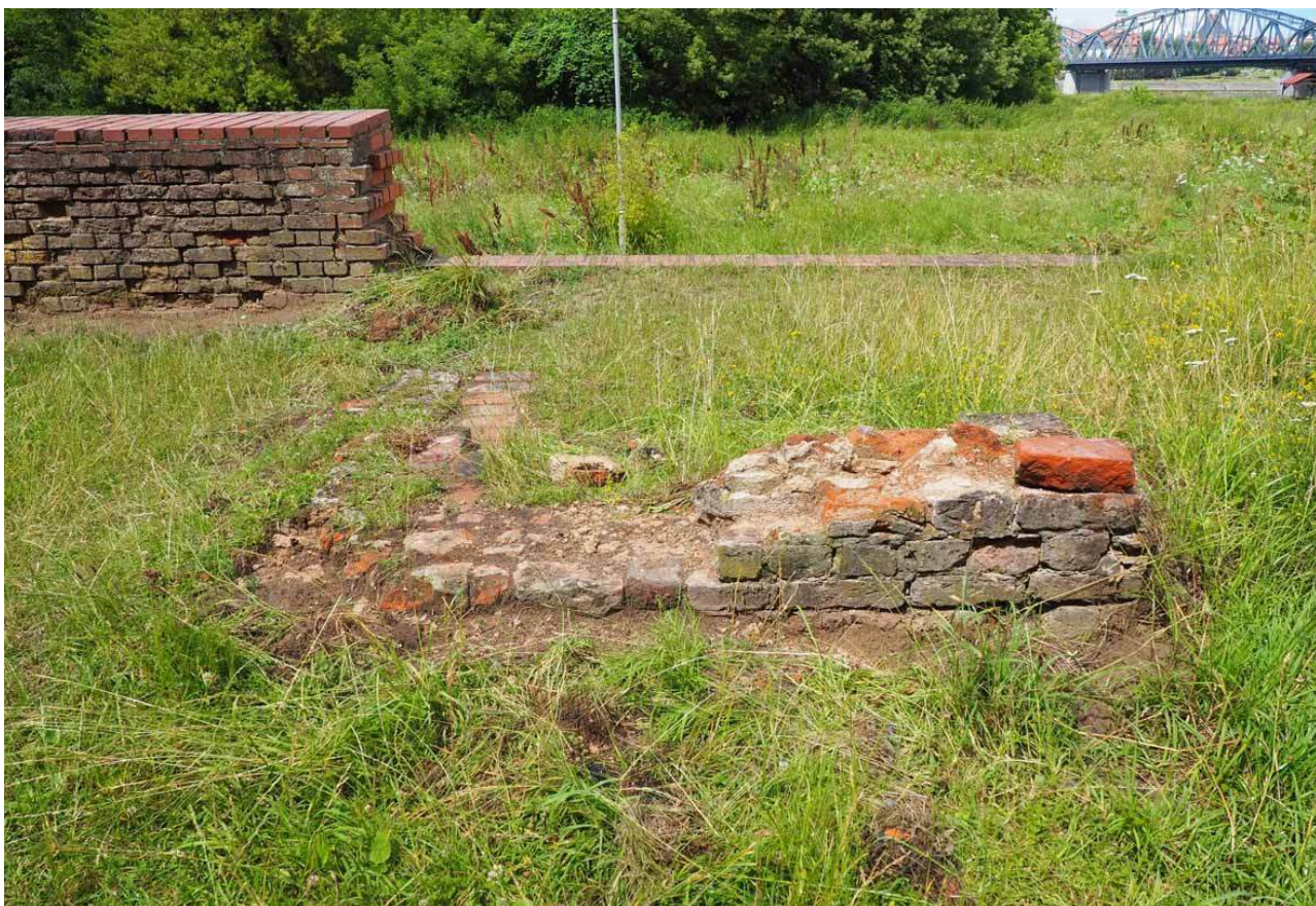
21. Zamek Dybowski. Relikty murów tworzących podziały wewnętrzne dawnego budynku mieszkalnego. Stan w sierpniu 2022 r. (Fot. P. Kofacz.)
