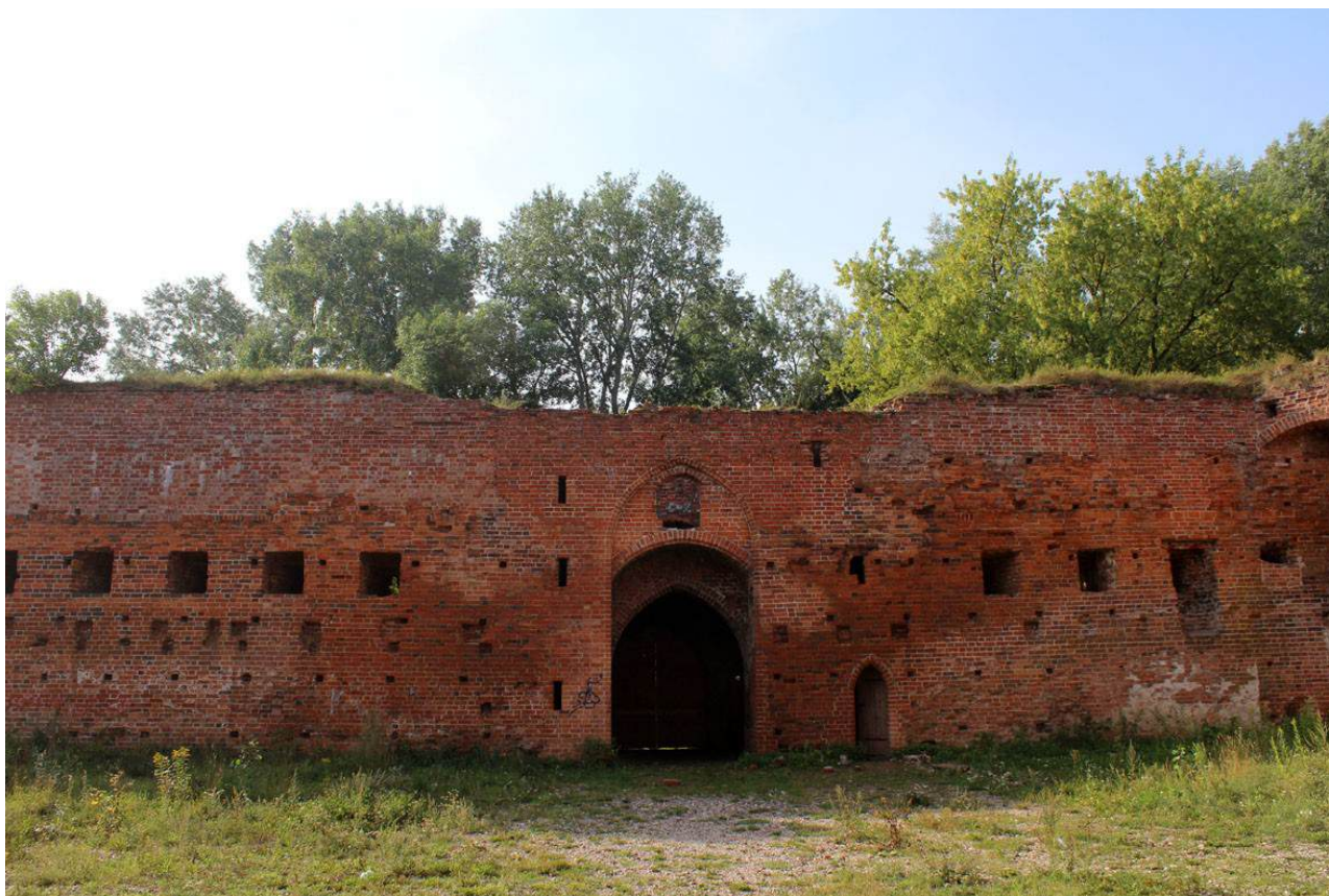
82. Zamek Dybowski. Mur południowy. Widoczna strefa wilgoci spowodowana prawdopodobnie zalewaniem muru od strony nieosłoniętego sklepienia wieży. Stan w sierpniu 2022 r. (Fot. E. Płocińska)
