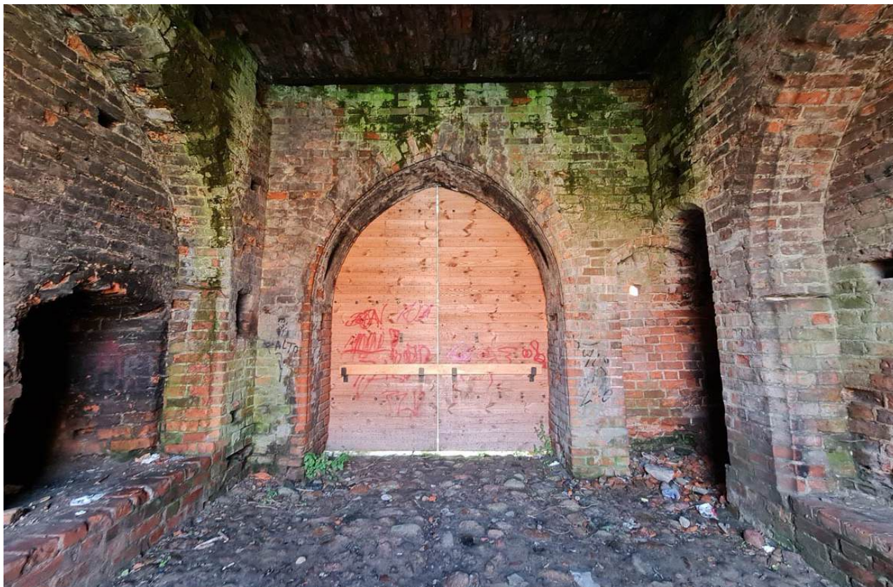
27. Zamek Dybowski. Przejazd wieży bramnej, ściana północna. Stan w sierpniu 2022 r. (Fot. E. Płocińska.)
