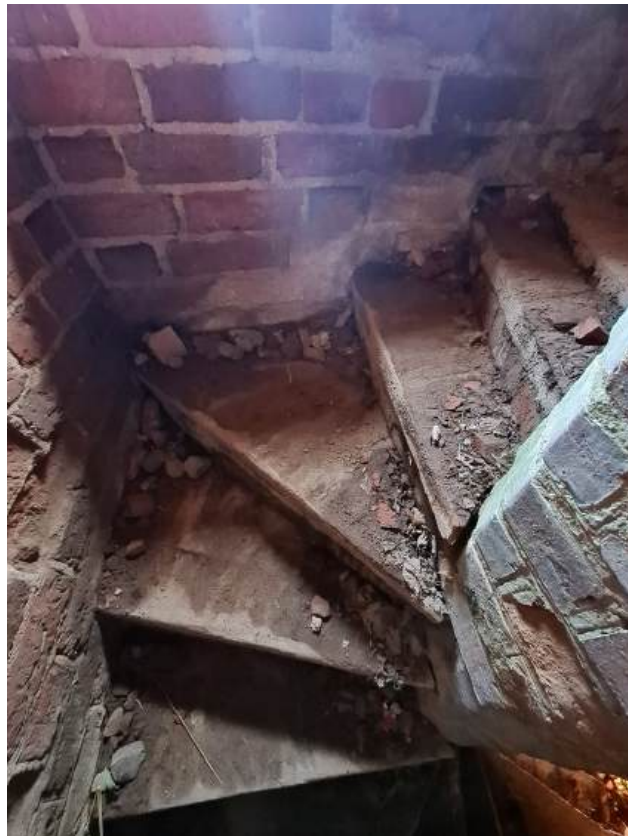
34. Zamek Dybowski. Klatka schodowa w murze, prowadząca na wieżę i koronę murów. Rekonstrukcja. Stan w sierpniu 2022 r. (Fot. E. Płocińska.)
