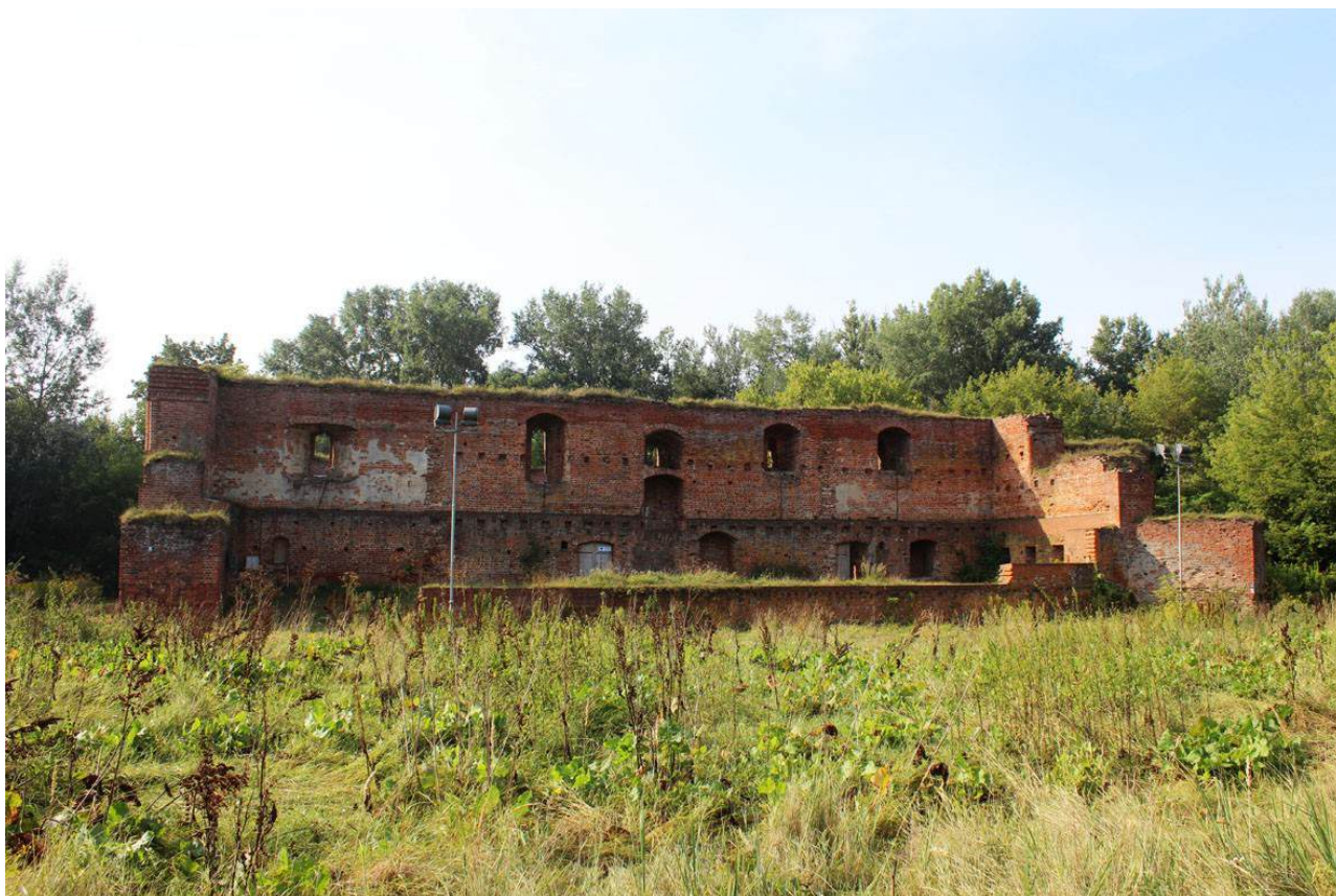
8. Zamek Dybowski. Północny mur obwodowy dziedzińca widoczny od strony Wisły. Stan w sierpniu 2022 r. (Fot. E. Płocińska.)
