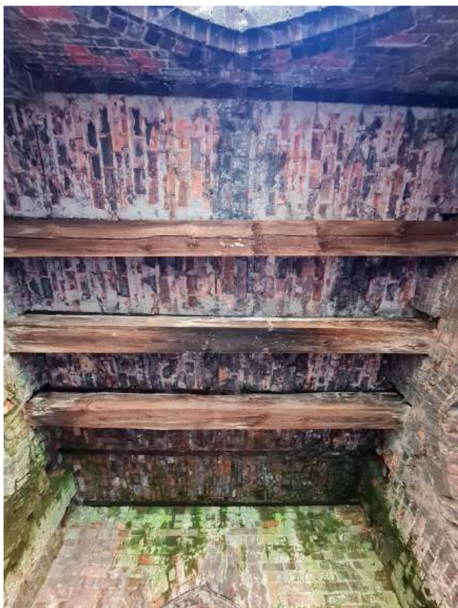
26. Zamek Dybowski. Rekonstruowane sklepienie wieży bramnej. Stan w sierpniu 2022 r. (Fot. E. Płocińska.)
