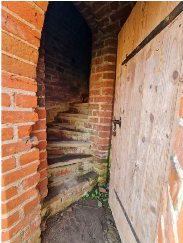
33. Zamek Dybowski. Klatka schodowa w murze, prowadząca na wieżę i koronę murów. Rekonstrukcja. Stan w sierpniu 2022 r. (Fot. E. Płocińska.)
