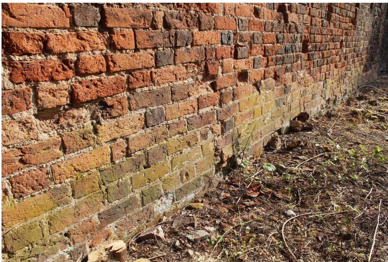
81. Zamek Dybowski. Wschodni odcinek muru południowego. Ślady infekcji biologicznej w partii przyziemia. Stan w sierpniu 2022 r. (Fot. E. Płocińska)
