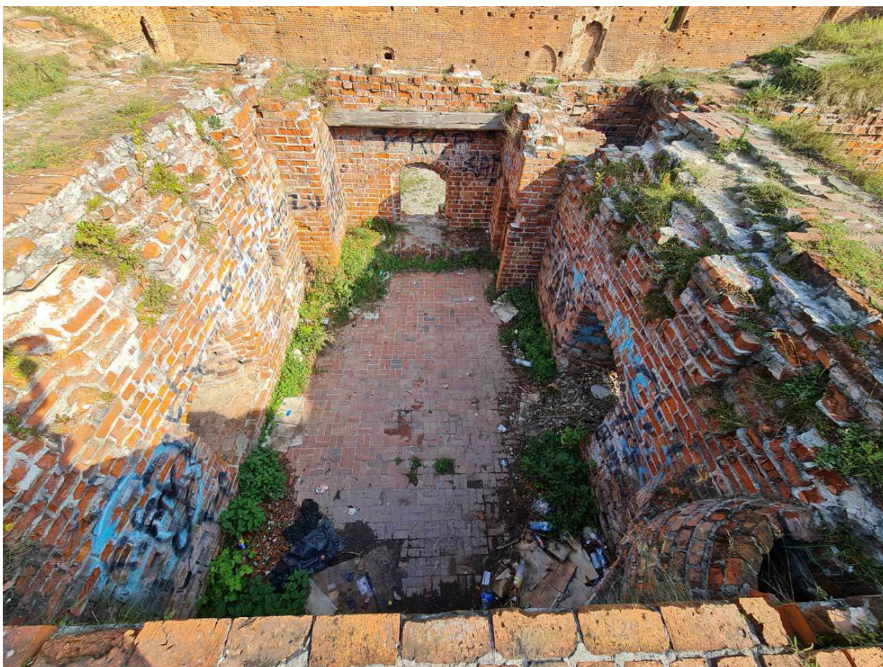
38. Zamek Dybowski. Rekonstruowana kondygnacja wieży. Stan w sierpniu 2022 r. (Fot. E. Płocińska.)
