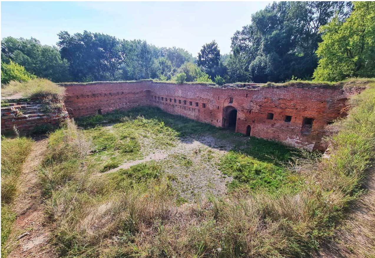
44. Zamek Dybowski. Widok ogólny dziedzińca zamkowego z poziomu korony murów. Stan w sierpniu 2022 r. (Fot. E. Płocińska.)
