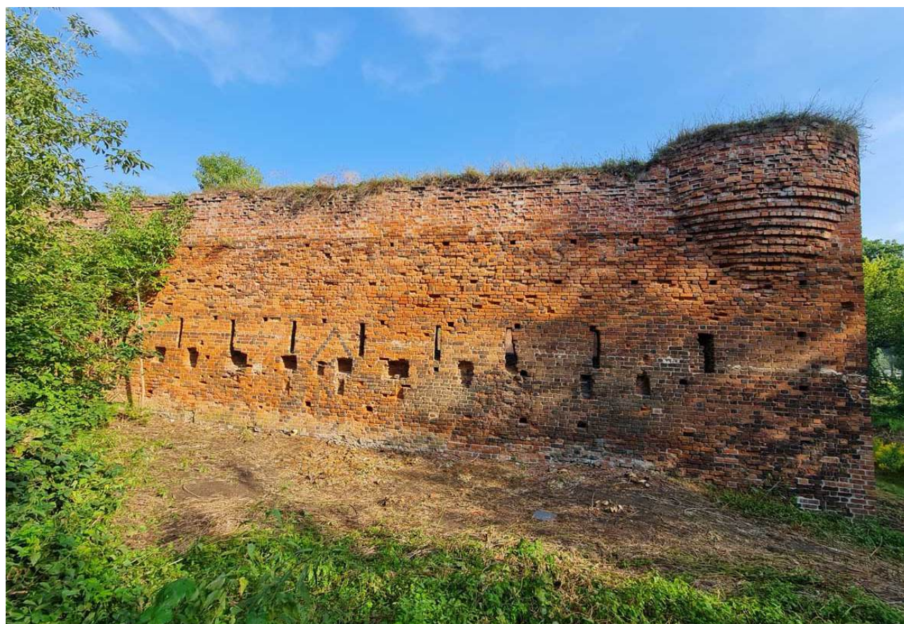
13. Zamek Dybowski. Południowy mur zabudowań w odcinku wschodnim. Widok od zewnątrz po usunięciu zarośli. Stan w sierpniu 2022 r. (Fot. E. Płocińska.)
