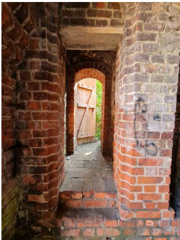
31. Zamek Dybowski. Otwór wyjściowy we wschodniej ścianie wieży. Stan w sierpniu 2022 r. (Fot. E. Płocińska.)
