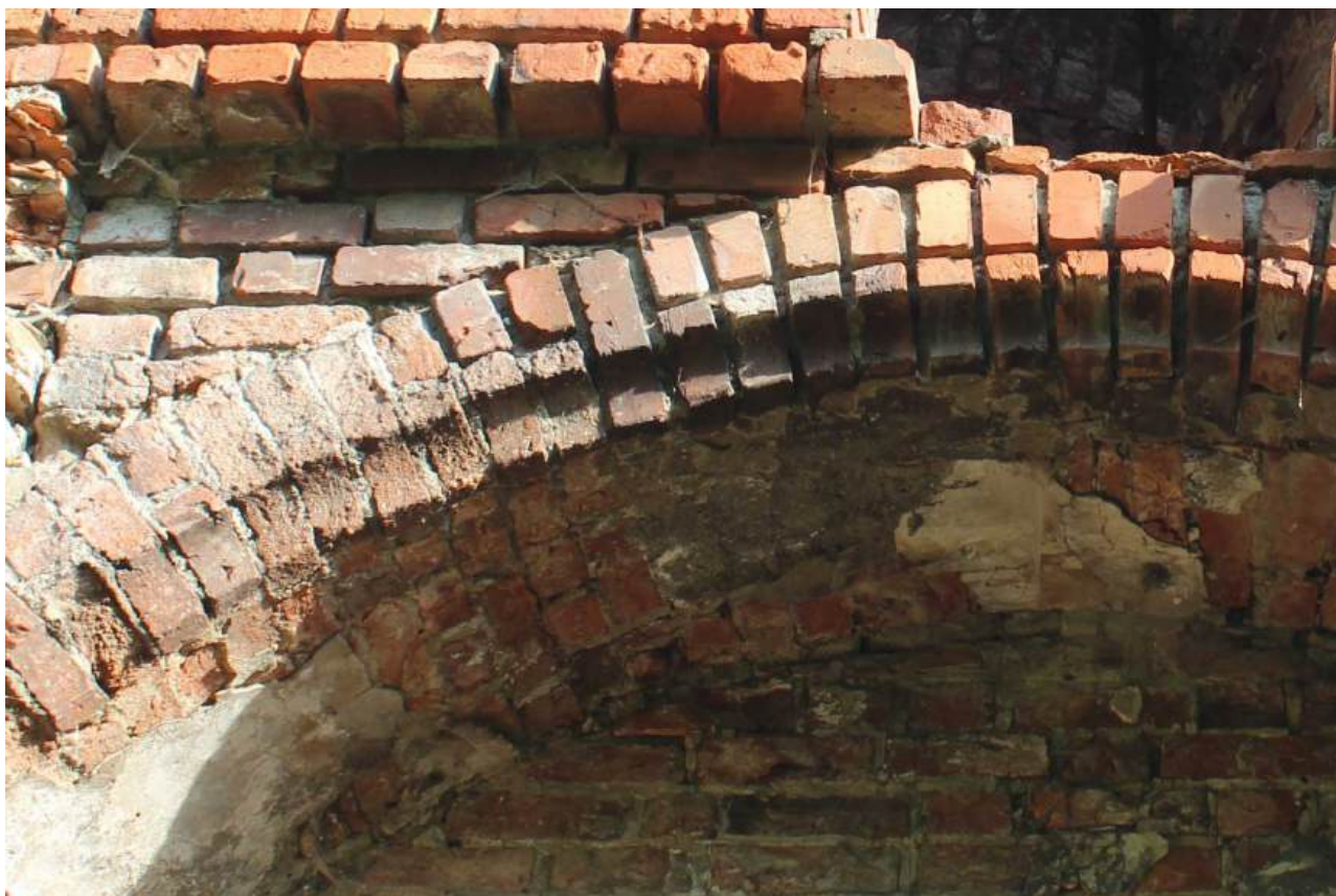
45. Zamek Dybowski. Kształtki ceramiczne profilowanie w formie wklęsli. Północna ściana wieży bramnej. Stan w sierpniu 2022 r. (Fot. E. Płocińska.)
