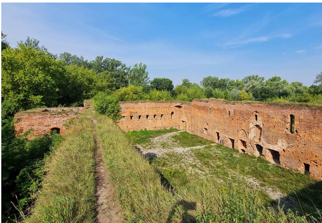
40. Zamek Dybowski. Widok ogólny dziedzińca zamkowego z poziomu korony murów. Stan w sierpniu 2022 r. (Fot. E. Płocińska.)
