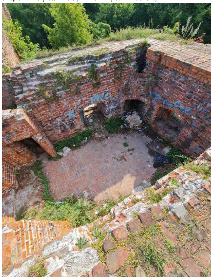
82. Zamek Dybowski. Mur południowy. Widoczna strefa wilgoci spowodowana prawdopodobnie zalewaniem muru od strony nieosłoniętego sklepienia wieży. Stan w sierpniu 2022 r. (Fot. E. Płocińska)
