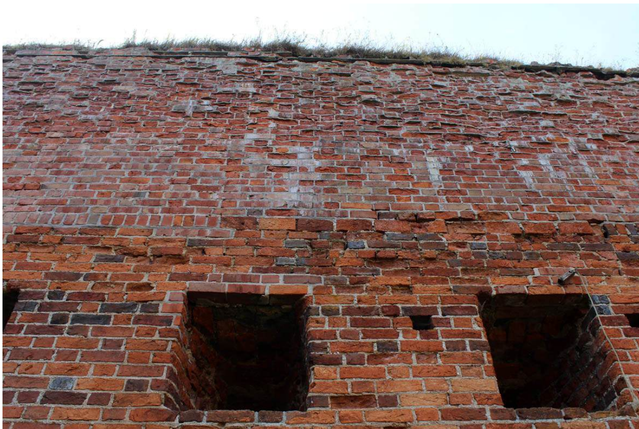
102. Zamek Dybowski. Zniszczenia cegły w obrębie lica murów. Widoczne białe wykwitki będące skutkiem wypłukiwania rozpuszczonych w wodzie składników zapraw. Destrukcja cegieł w partii korony i izolacji poziomej muru. Stan w sierpniu 2022 r. (Fot. E. Płocińska)
