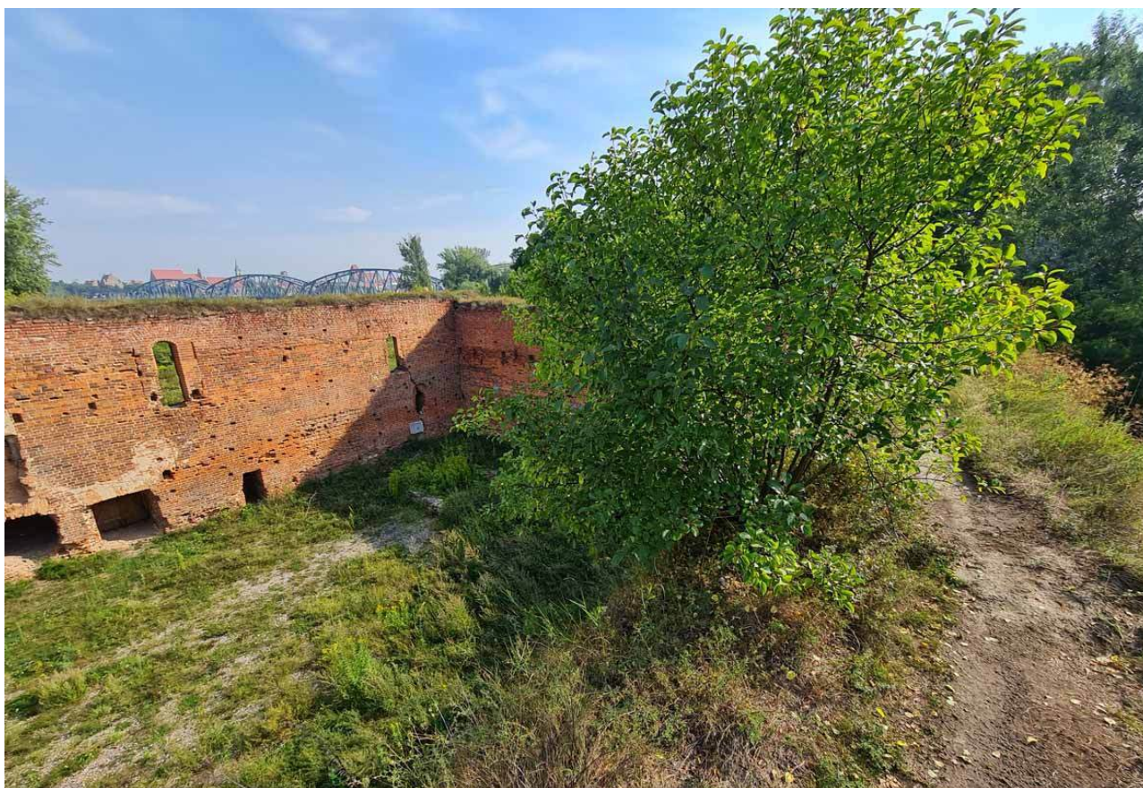
85. Zamek Dybowski. Mur południowy. Roślinność porastająca koronę murów. Stan w sierpniu 2022 r. (Fot. E. Płocińska)
