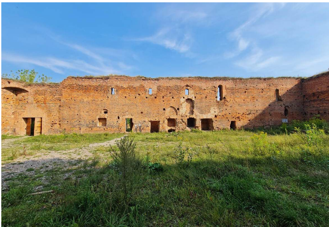
9. Zamek Dybowski. Północny mur obwodowy. Widok od dziedzińca. Stan w sierpniu 2022 r. (Fot. E. Płocińska.)
