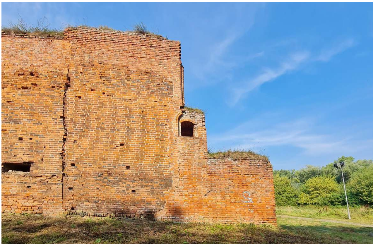
75. Zamek Dybowski. Wschodni mur obwodowy. Widoczna szczelina w murze w miejscu dołączenia muru do pierwotnej ściany budynku mieszkalnego. Stan w sierpniu 2022 r. (Fot. E. Płocińska)
