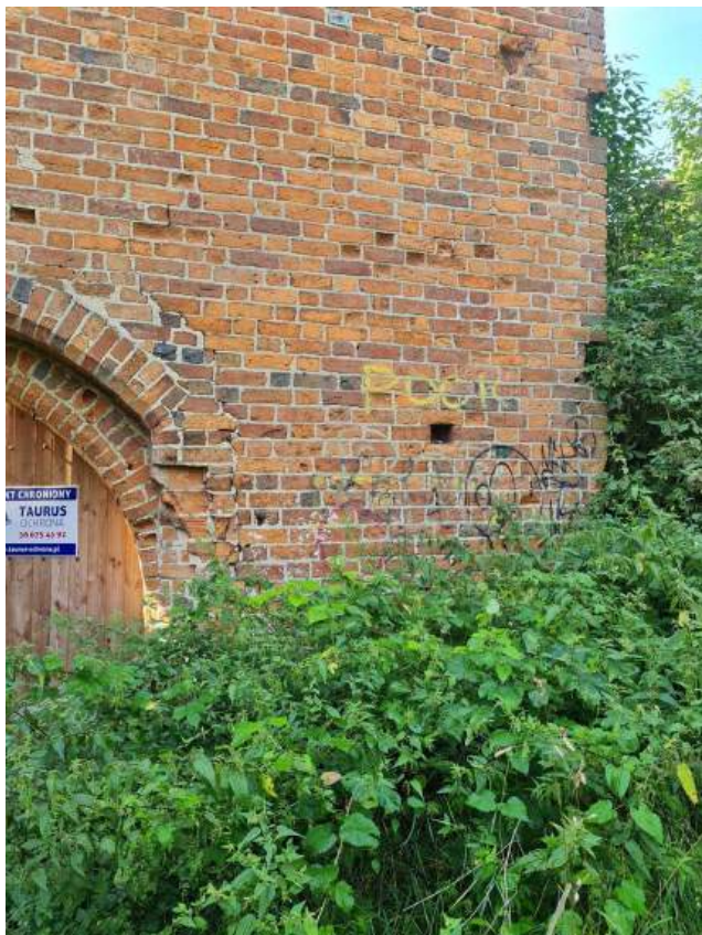
112. Zamek Dybowski. Zniszczenia lica ceglanego wskutek aktów wandalizmu. Stan w sierpniu 2022 r. (Fot. E. Płocińska)
