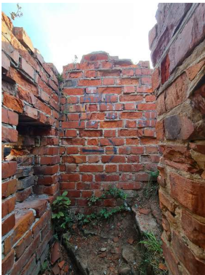
102. Zamek Dybowski. Zniszczenia cegły w obrębie lica murów. Widoczne białe wykwitki będące skutkiem wypłukiwania rozpuszczonych w wodzie składników zapraw. Destrukcja cegieł w partii korony i izolacji poziomej muru. Stan w sierpniu 2022 r. (Fot. E. Płocińska)
