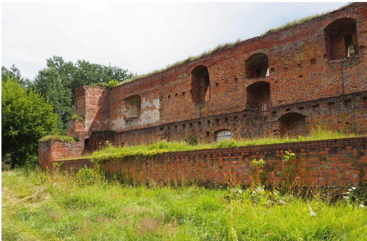
22. Zamek Dybowski. Relikty północnej ściany dawnego budynku mieszkalnego. Stan w sierpniu 2022 r. (Fot. P. Kołacz.)
