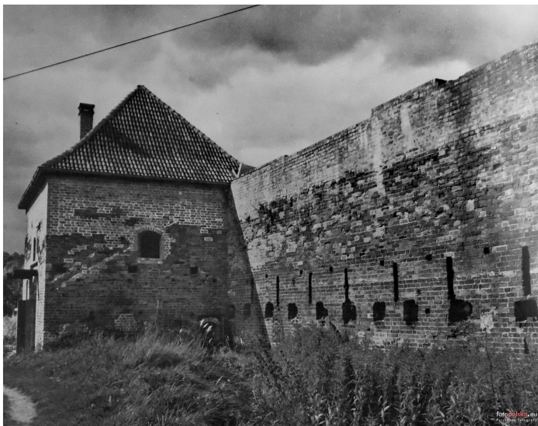
Zdjęcie 1. Archiwalne zdjęcie wieży bramnej, widok od strony wschodniej.
