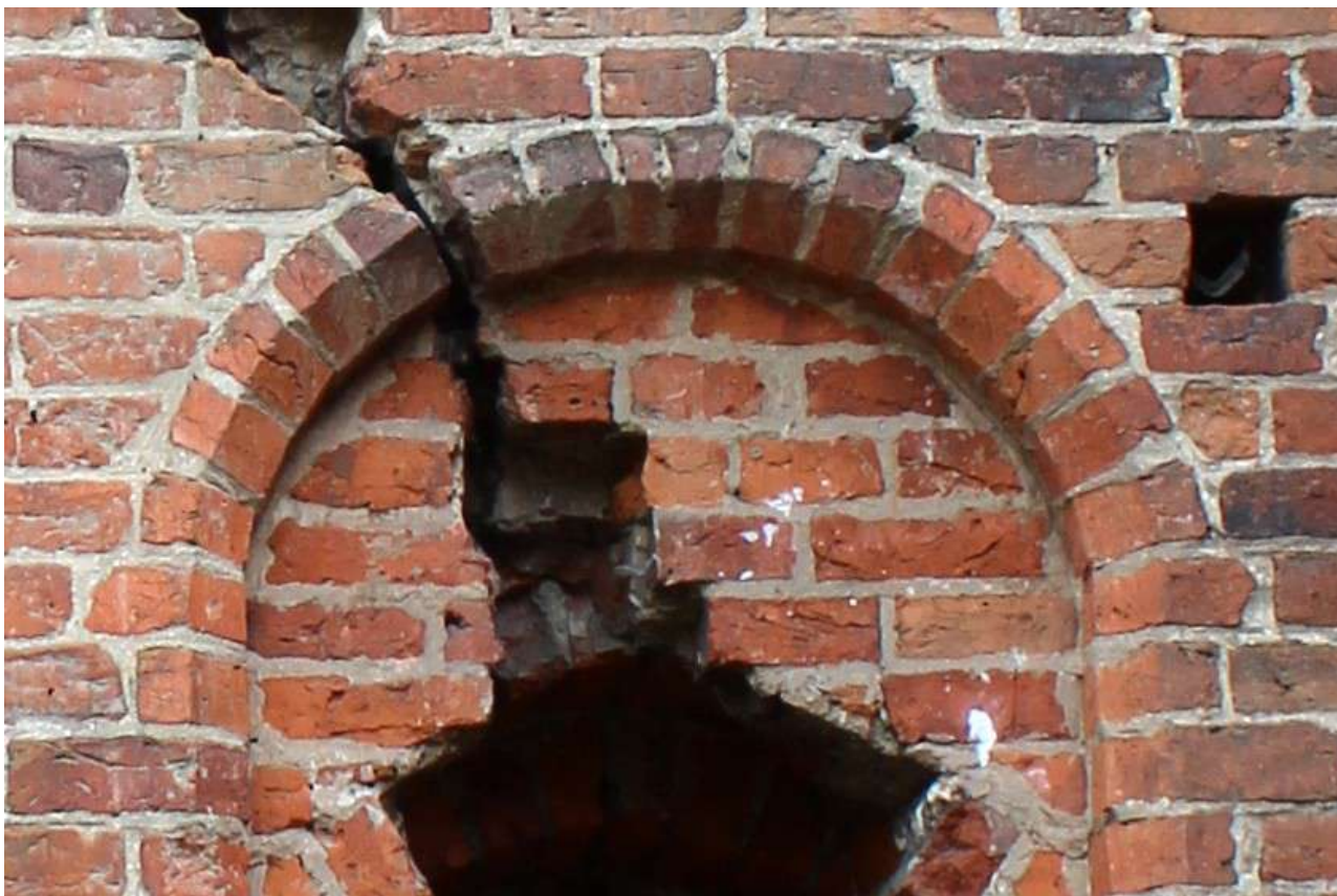
47. Zamek Dybowski. Kształtki ceramiczne profilowane w formie fazowania. Północny mur obwodowy od strony dziedzińca. Stan w sierpniu 2022 r. (Fot. E. Płocińska.)
