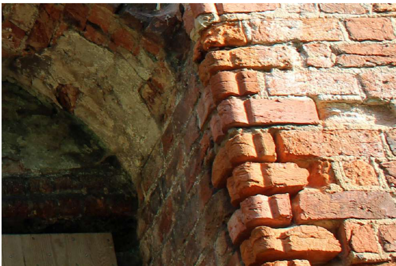
46. Zamek Dybowski. Kształtki ceramiczne profilowanie w formie wałka. Północna ściana wieży bramnej. Stan w sierpniu 2022 r. (Fot. E. Płocińska.)
