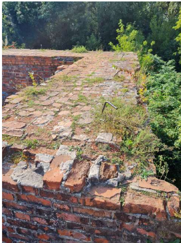
91. Zamek Dybowski. Stan zachowania korony murów. Sierpień 2022 r. (Fot. E. Płocińska)
