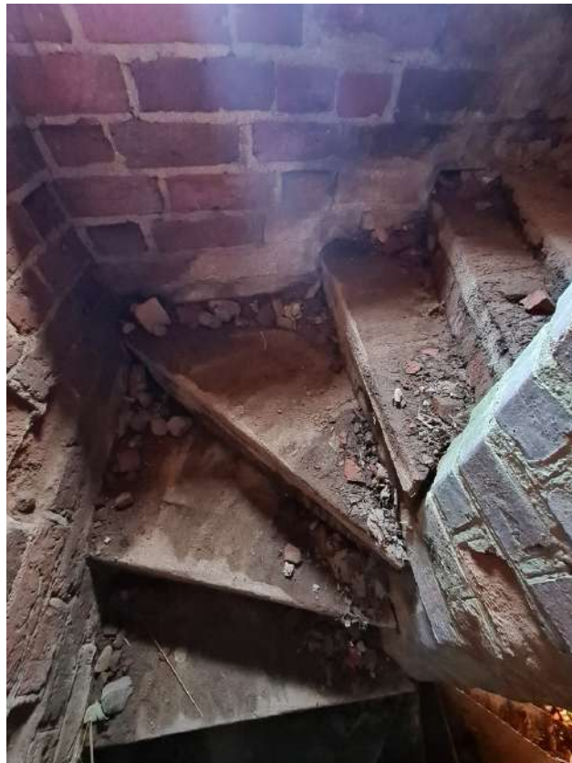
34. Zamek Dybowski. Klatka schodowa w murze, prowadząca na wieżę i koronę murów. Rekonstrukcja. Stan w sierpniu 2022 r. (Fot. E. Płocińska.)
