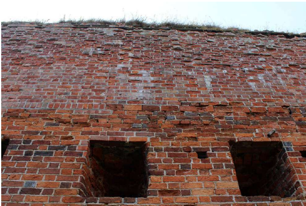
102. Zamek Dybowski. Zniszczenia cegły w obrębie lica murów. Widoczne białe wykwitły będące skutkiem wypłukiwania rozpuszczonych w wodzie składników zapraw. Destrukcja cegieł w partii korony i izolacji poziomej muru. Stan w sierpniu 2022 r. (Fot. E. Płocińska)
