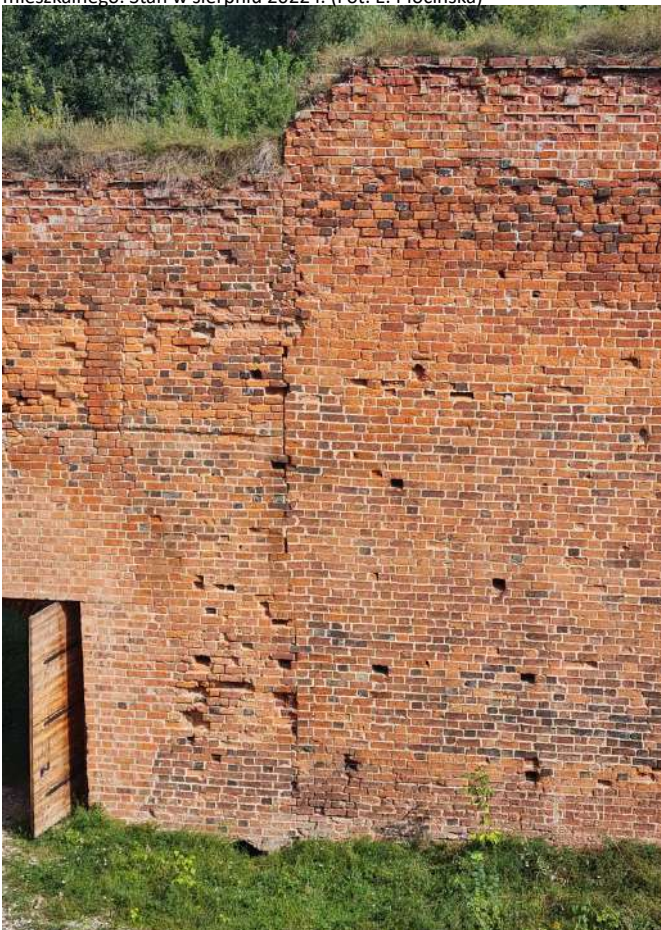
75. Zamek Dybowski. Wschodni mur obwodowy. Widoczna szczelina w murze w miejscu dołączenia muru do pierwotnej ściany budynku mieszkalnego. Stan w sierpniu 2022 r. (Fot. E. Płocińska)
