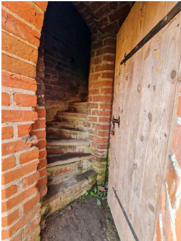
33. Zamek Dybowski. Klatka schodowa w murze, prowadząca na wieżę i koronę murów. Rekonstrukcja. Stan w sierpniu 2022 r. (Fot. E. Płocińska.)
