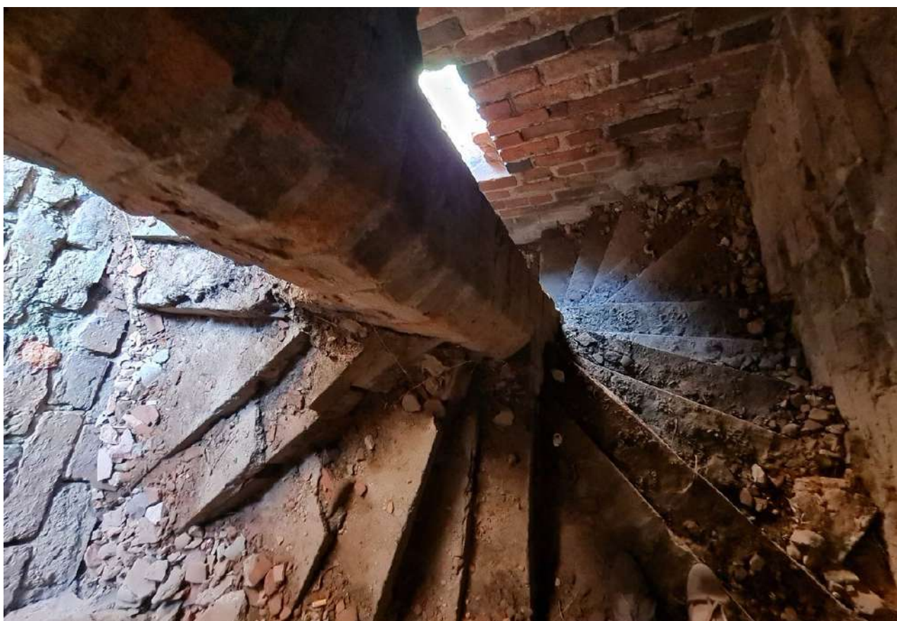
36. Zamek Dybowski. Klatka schodowa w murze, prowadząca na wieżę i koronę murów. Rekonstrukcja. Stan w sierpniu 2022 r. (Fot. E. Płocińska.)
