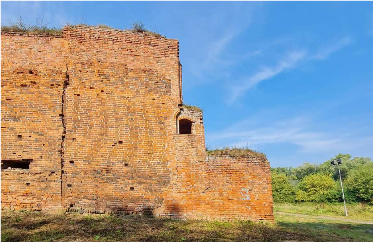
75. Zamek Dybowski. Wschodni mur obwodowy. Widoczna szczelina w murze w miejscu dołączenia muru do pierwotnej ściany budynku mieszkalnego. Stan w sierpniu 2022 r. (Fot. E. Płocińska)
