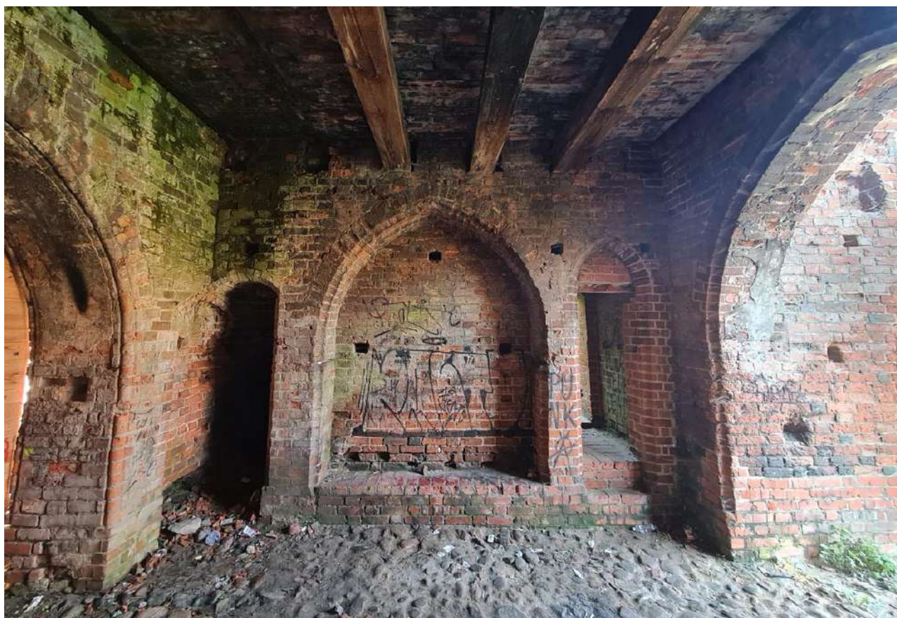
28. Zamek Dybowski. Przejazd wieży bramnej, ściana zachodnia. Częściowa rekonstrukcja. Stan w sierpniu 2022 r. (Fot. E. Płocińska.)
