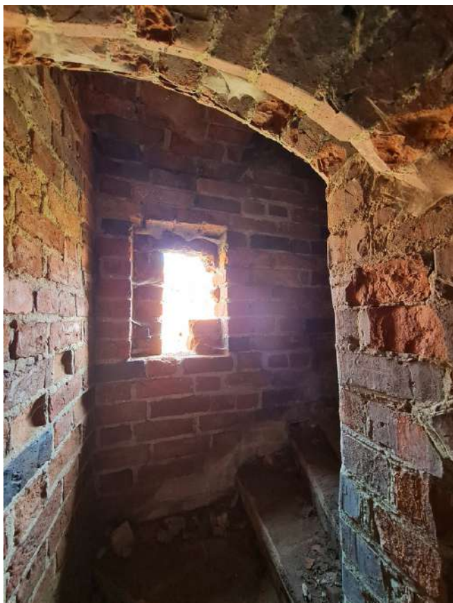
35. Zamek Dybowski. Klatka schodowa w murze, prowadząca na wieżę i koronę murów. Rekonstrukcja. Stan w sierpniu 2022 r. (Fot. E. Płocińska.)
