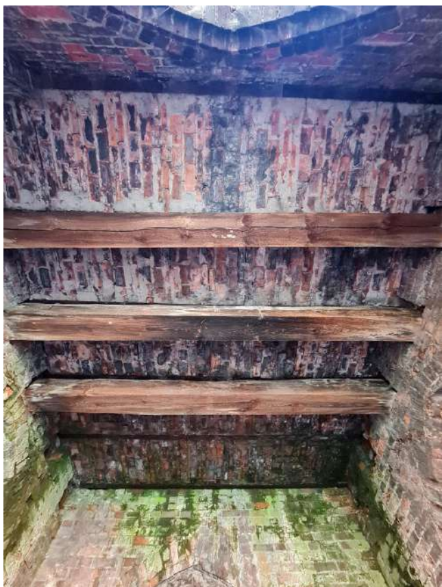
26. Zamek Dybowski. Rekonstruowane sklepienie wieży bramnej. Stan w sierpniu 2022 r. (Fot. E. Płocińska.)
