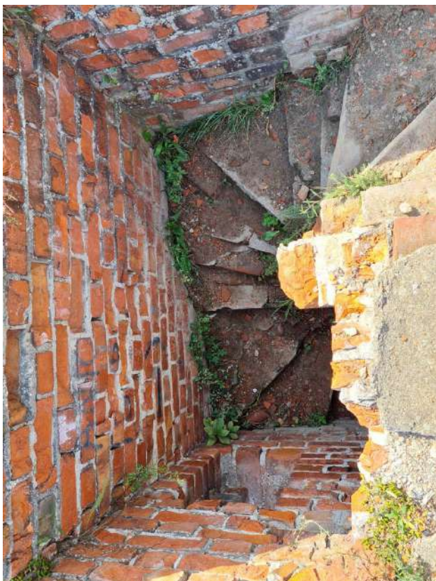
37. Zamek Dybowski. Klatka schodowa w murze, prowadząca na wieżę i koronę murów. Rekonstrukcja. Stan w sierpniu 2022 r. (Fot. E. Płocińska.)
