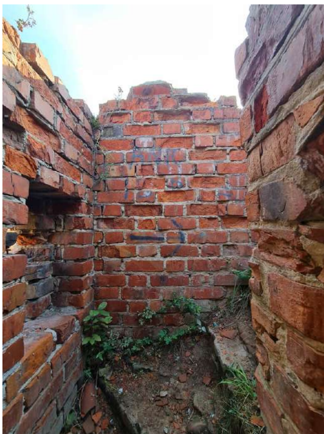
102. Zamek Dybowski. Zniszczenia cegły w obrębie lica murów. Widoczne białe wykwitły będące skutkiem wypłukiwania rozpuszczonych w wodzie składników zapraw. Destrukcja cegieł w partii korony i izolacji poziomej muru. Stan w sierpniu 2022 r. (Fot. E. Płocińska)
