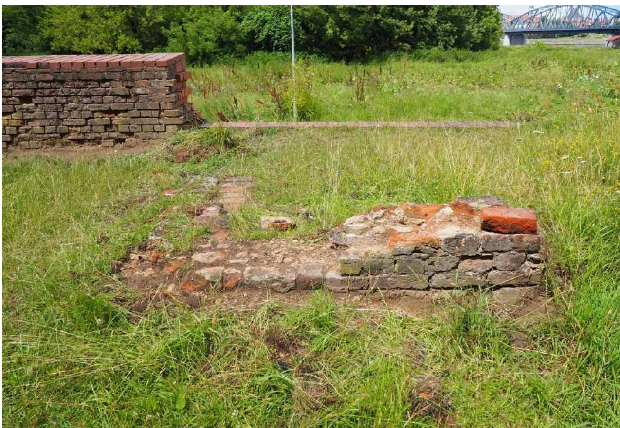
21. Zamek Dybowski. Relikty murów tworzących podziały wewnętrzne dawnego budynku mieszkalnego. Stan w sierpniu 2022 r. (Fot. P. Kofacz.)
