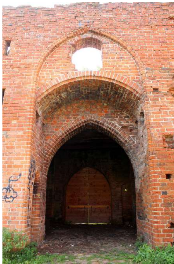
25. Zamek Dybowski. Rekonstruowany przejazd wieży bramnej. Widok od strony dziedzińca. Stan w sierpniu 2022 r. (Fot. E. Płocińska.)
